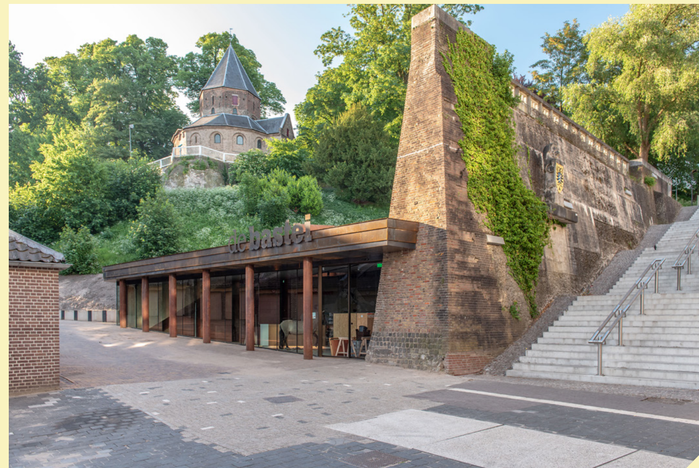
De Bastei Fotograaf: Mertens Bouw
